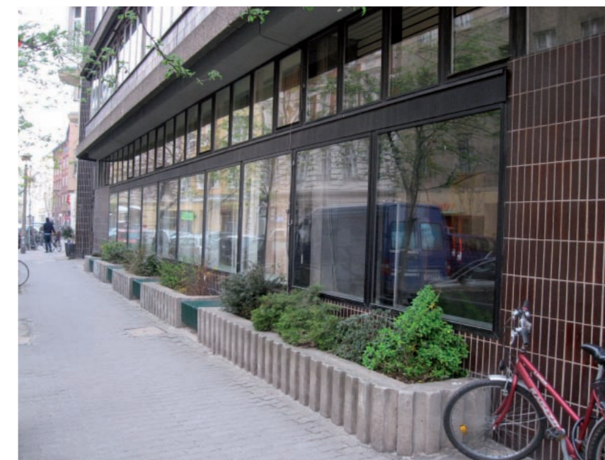
Aussenanlage vor dem Umbau
